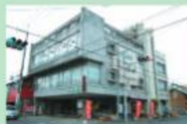
14 本町 明治時代建築の建物。昭和初期に一般化されている。
