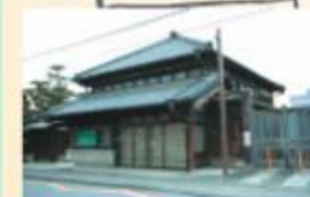
10 本町 明治時代建築の建物。昭和初期に一般化されている。
