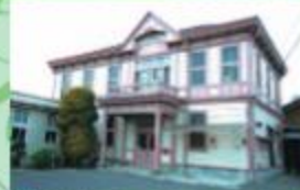
6 本町 明治時代建築の建物。昭和初期に一般化されている。
